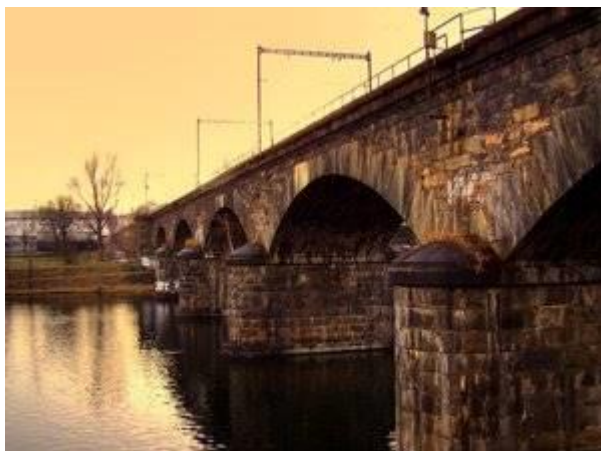
Viadukto de Negrelli, Prago
