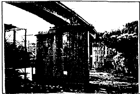
La finkonstruita betonponto duonvoje ŝovita de la help-pileroj al la malnovaj pilieroj
